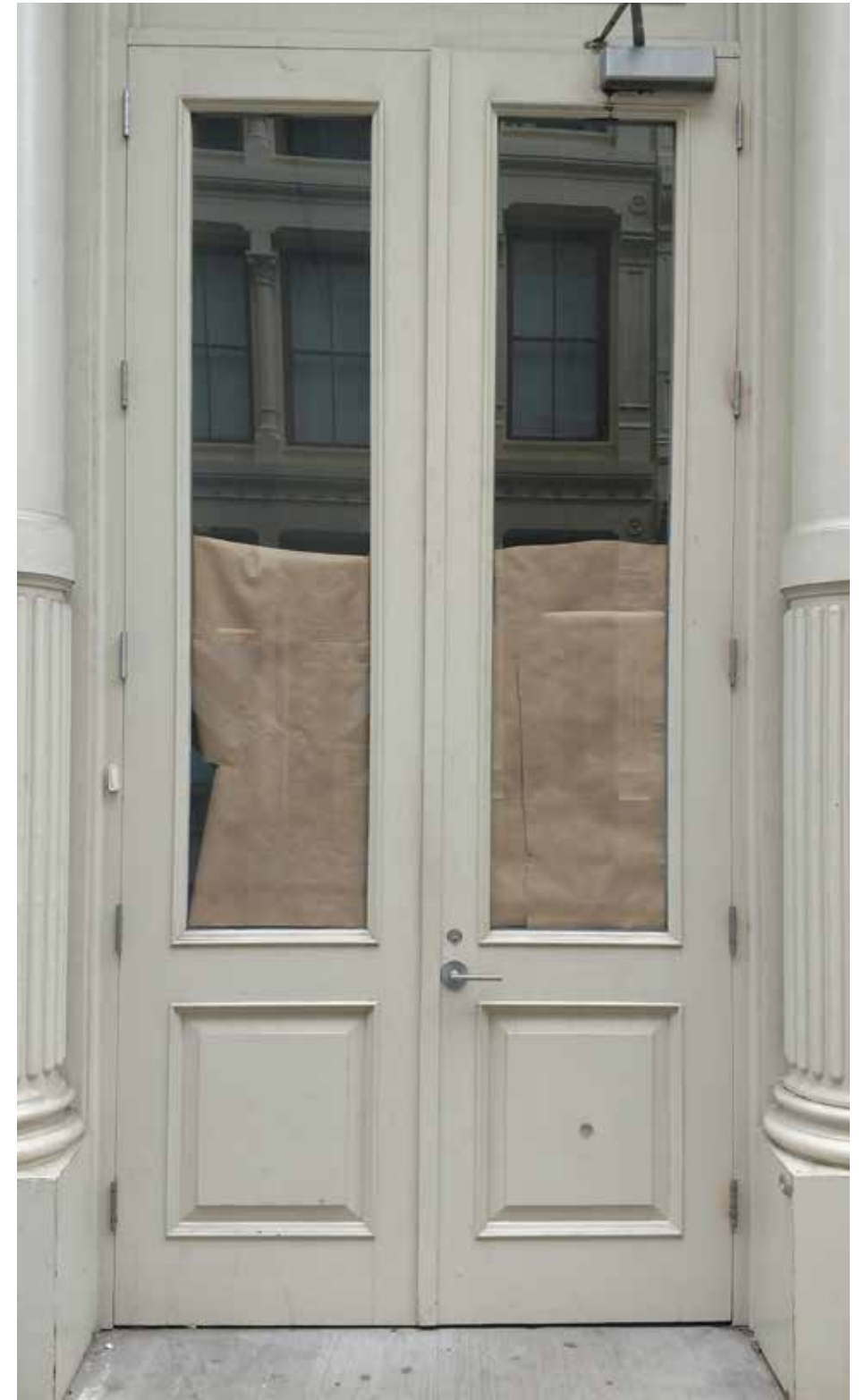
EXISTING STOREFRONT DOOR
